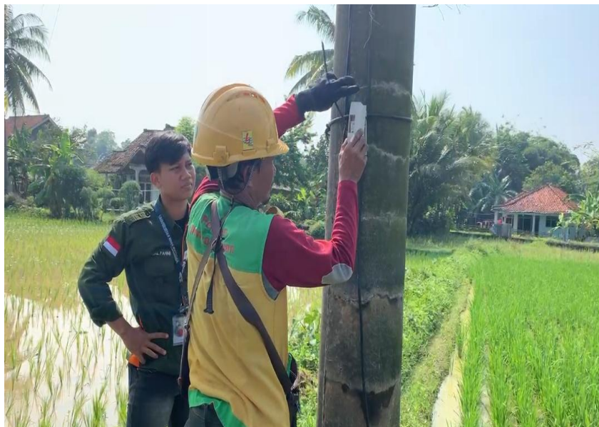
Gambar 7 Pemasangan MCB pada tiang SUTM
